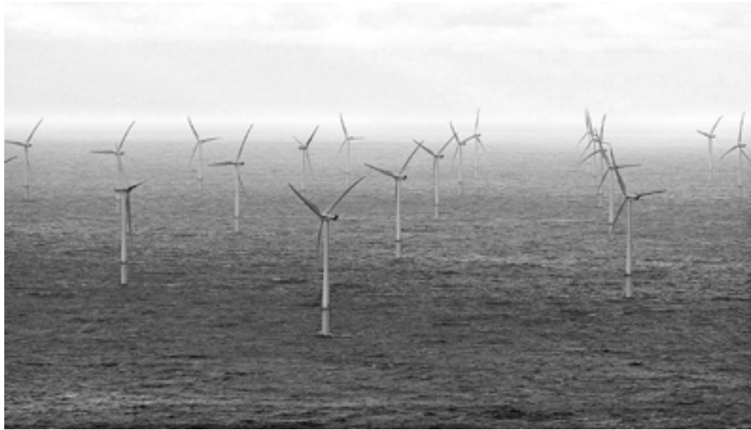
Vista aérea de los molinos de viento de Belwind en un parque eólico marino en la costa de Zeebrugge, Bélgica. * FOTO: EFE, NICOLÁS MAETTERLINCK
