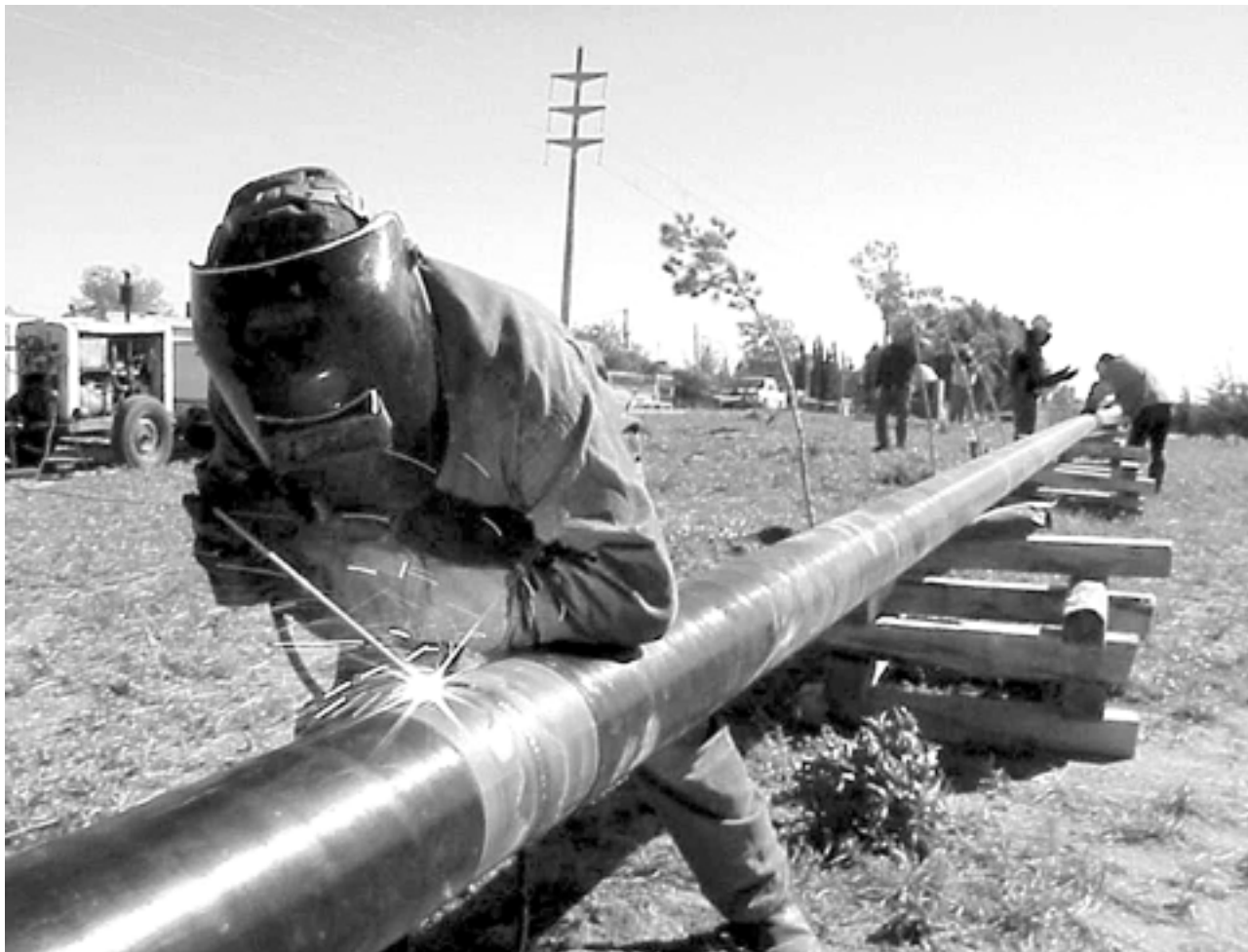
Obras en un gasoducto en la provincia de San Luis, Argentina. ★ FOTO: HTTP://WWW.INFRAESTRUCTURA.SANLUIS.GOV.AR
